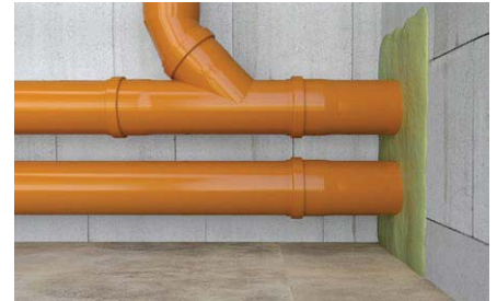
Riempimento di attraversamenti di tubazioni.
