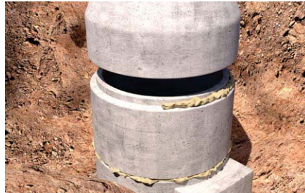
Sigillatura anelli di pozzetti di calcestruzzo.
