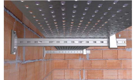
Staffaggio di impianti elettrici.
