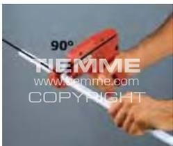
Il taglio del tubo deve essere eseguito perpendicolare all'asse dello stesso. Evitare assolutamente l'utilizzo di seghetti o mole a disco che potrebbero deformare il tubo.
