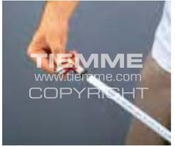
Inserire il tubo nel raccordo finché non arriva in battuta (verificare attraverso la "finestra" della ghiera)
