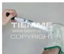
Ripristinare la forma del tubo utilizzando l'apposito calibratore. Particolare attenzione nell'esecuzione dell'operazione di calibratura e sbavatura del tubo, da eseguire con gli appositi attrezzi. Eventuale residuo di bava potrebbe danneggiare gli o-ring.
